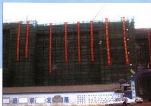
建设中的文科组团行政办公楼
