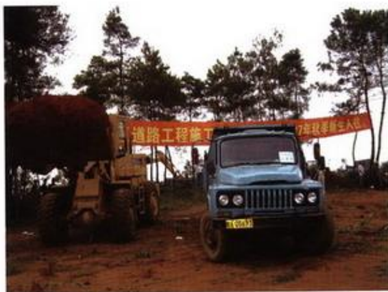
雁山校区第一期道路管网工程开工现场
