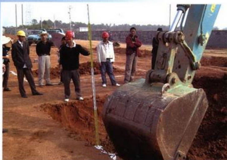
雁山校区文科组团行政办公大楼破土动工
